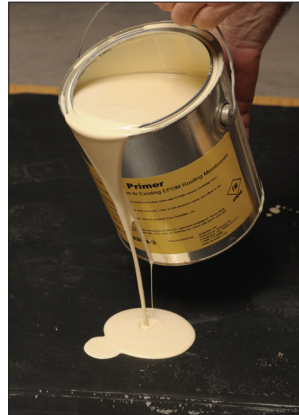
Pour EPDM Primer out of can onto substrate
